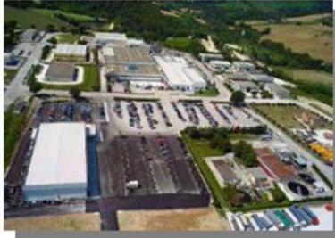
Stabilimento di Cingoli (MC)
